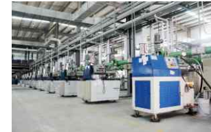
■ 实创科技生产机器设备
